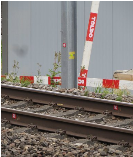
Messpunkte für Gleis- und Mastüberwachung
