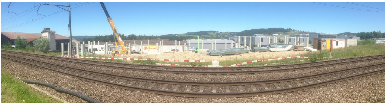
Baustelle Postlogistik Center
